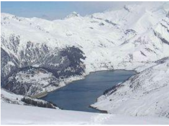
Barrage de Roselend
